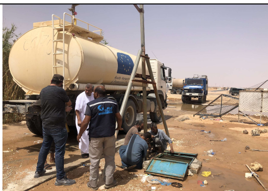
Reparación de puntos de carga de cisternas
